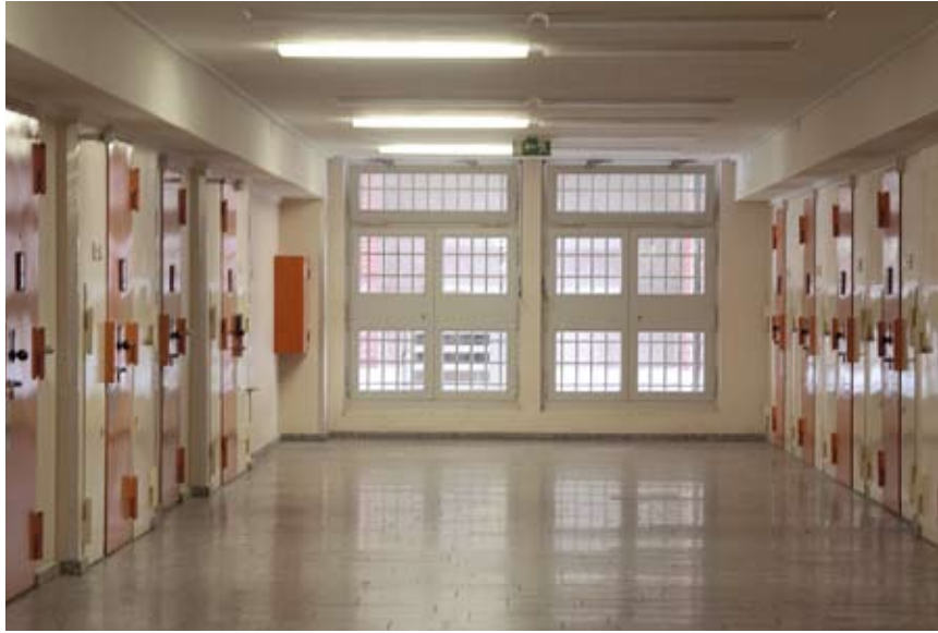
Insgesamt 423 Hafträume umfasst der Bereich der Teilanstalt II
